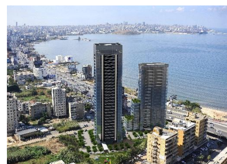
Tours Crystal - Antelias – LIBAN – 75m et 100m de Hauteur Deux Tours composées d'une Tour Résidentielle sur 35 étages et d'une tour de bureaux étalée sur 25 étages.
